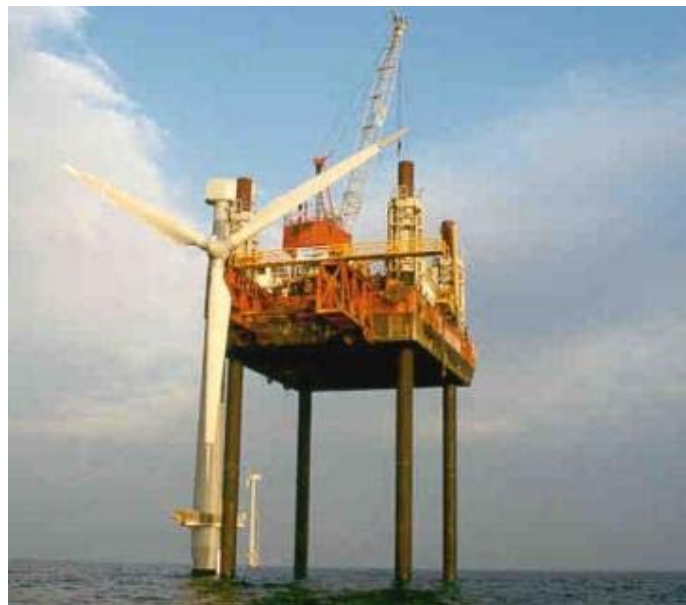
Abb. 3.3 Jack-Up-Plattform im Bockstigen Windpark mit Monopile-Gründung [www.seacore.co.uk].
