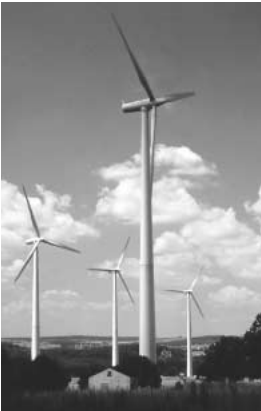
Gruppe von vier Windkraftanlagen mit je 600 Kilowatt Nennleistung und 58 Meter Nabenhöhe bei Herbstein/ Vogelsberg in Hessen (Windpark Rixfeld)
